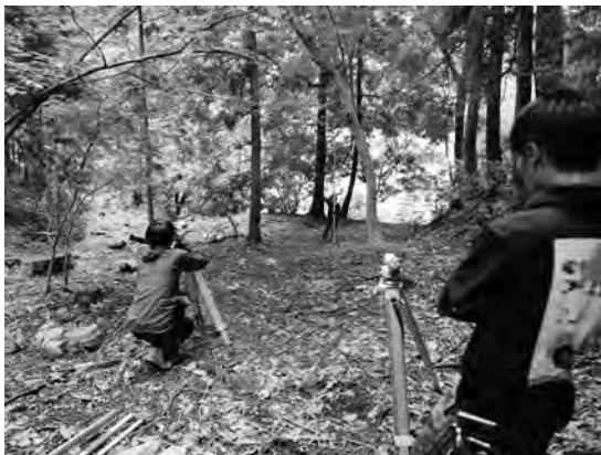
写真1 基準点測量の様子
