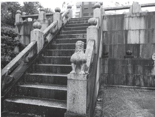
写真2 護国塔の入口手すり
