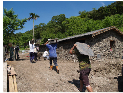
図 22 2005年に常民家屋が再建するとき、人々石板を運ぶ様子（右）
