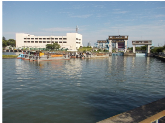
写真 2-10 大川東岸（北部）
