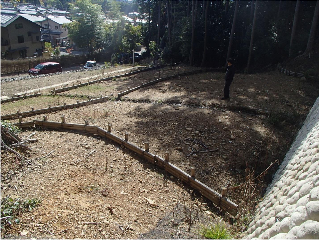
図 2-2-2 試験区設置前の研究対象地の様子（2015年11月）
