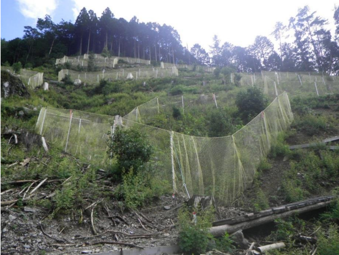
図 1-6 パッチディフェンスの設置例
