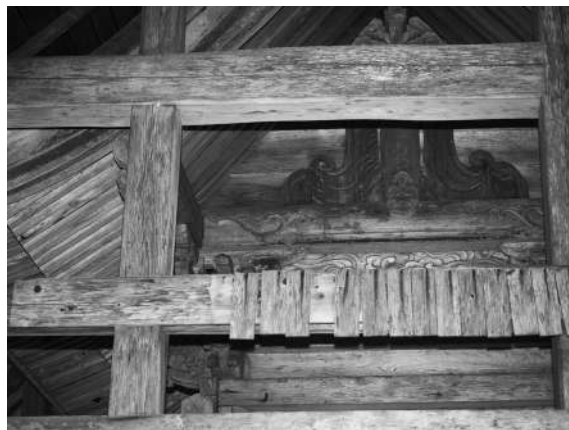
写真2 五霊神社本殿身舎妻面詳細
