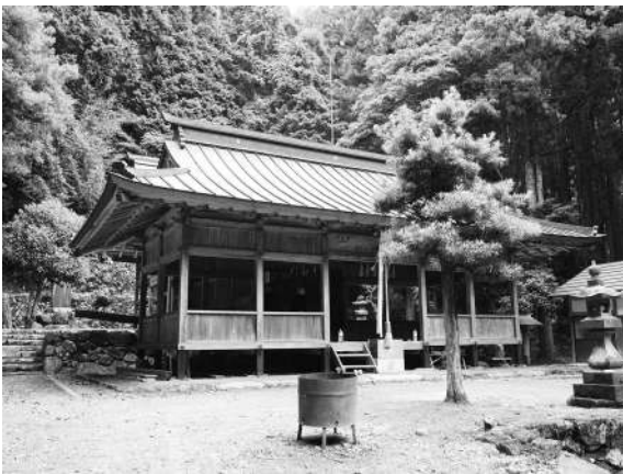
写真9 五霊神社拝殿全景
