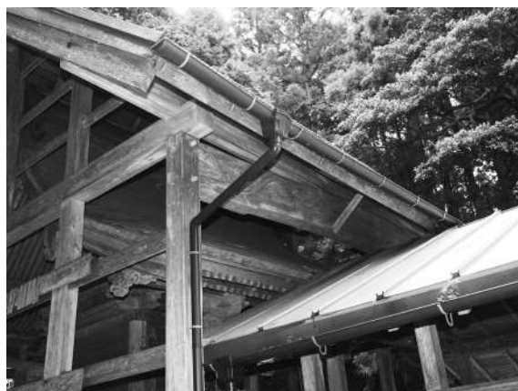
写真6 五霊神社本殿覆屋虹梁絵様
