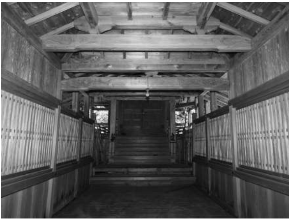
写真7 五霊神社幣殿内部
