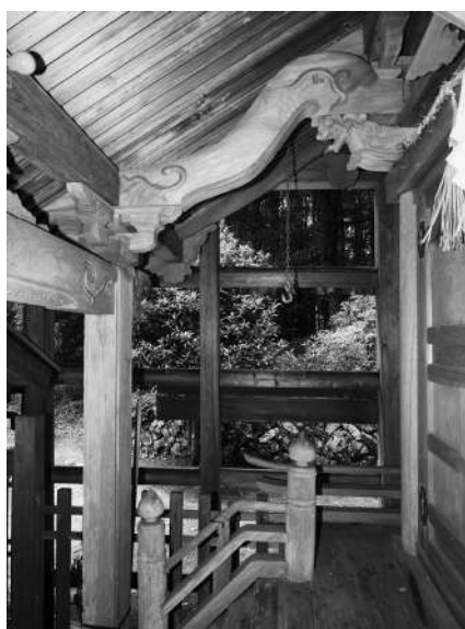
写真4 五霊神社本殿繫海老虹梁
