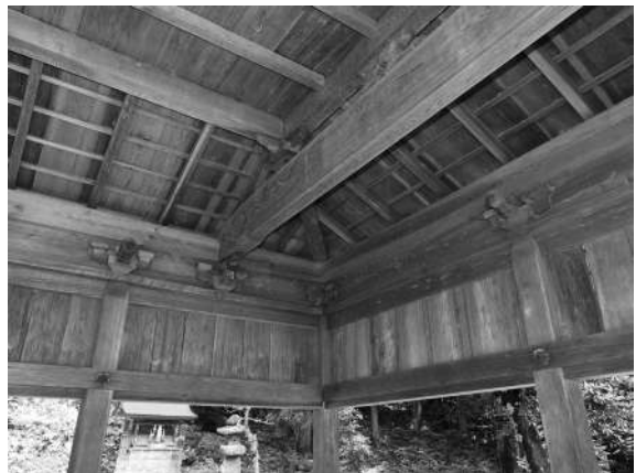
写真12 五霊神社拝殿隅部天井架構詳細
